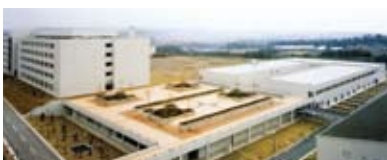
豊田中央研究所 実験棟
